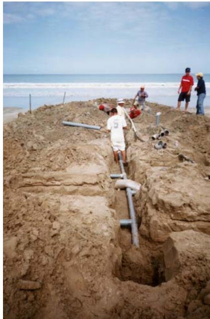
Anexo 43. Instalación de las puntas en la costa de la playa.
