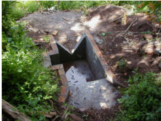
Foto 1. Vertedero de flujo a la salida del drenaje con cobertura Inga
