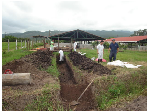
Figura 4. Fosa destinada a alojamiento del biodigestor tipo Taiwán
