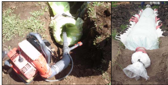
Figura 9. Llenado de aire al tubular de polietileno de baja densidad.
