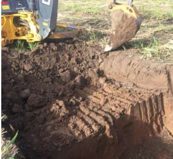
Anexo 1. Extracción del suelo con maquinaria.
