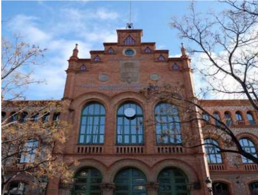
Figura 2. Instituto Politécnico Campus Terrassa (IPCT).
