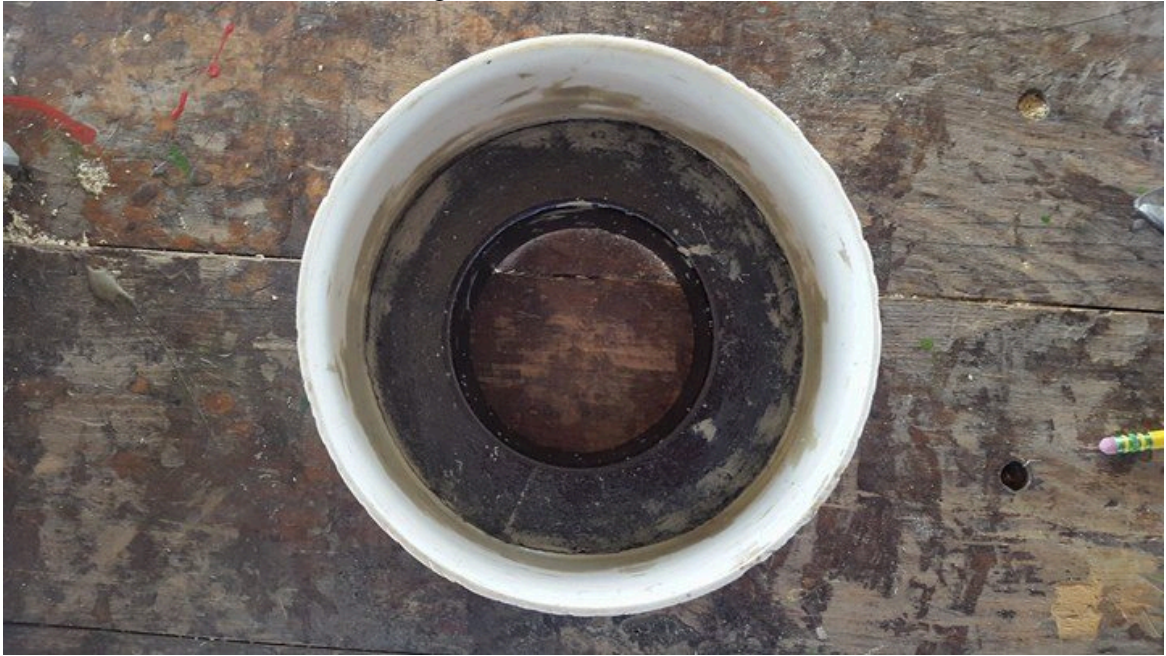
Anexo 1. Tubo de PVC de descarga donde se ubican los filtros.
