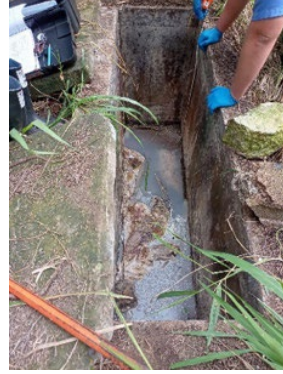
Imágenes de la Fosa Séptica de la Planta de Lácteos de Zamorano
