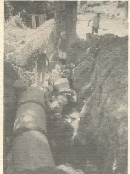
Colocación de tubería para canalización de aguas lluvias en la calle El Quebracho, Jicarito.
