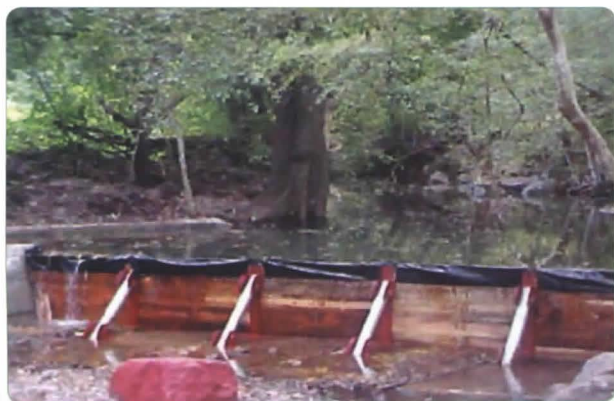
Foto 1. Presa provisional de madera en un río para aumentar el nivel de almacenamiento.
