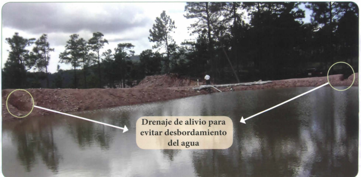
Foto 7. Drenaje de auxilio en la borda de la laguna.
