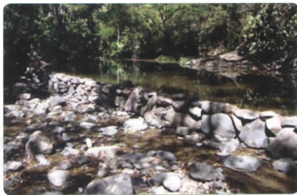
Foto 2. Presa provisional de piedra y lodo en río de Alubarén, Francisco Morazán, Honduras.
