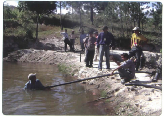
Foto 6. Instalación de tubería para conducción del agua de la laguna hacia las parcelas.
