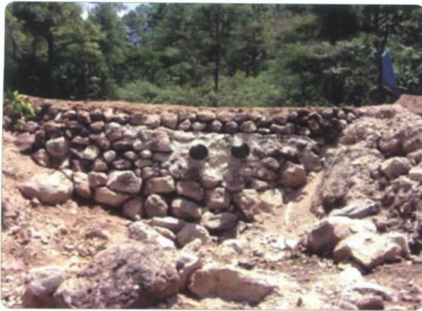
Foto 5. Borda de tierra, piedra y cemento construida en un vaso natural.
