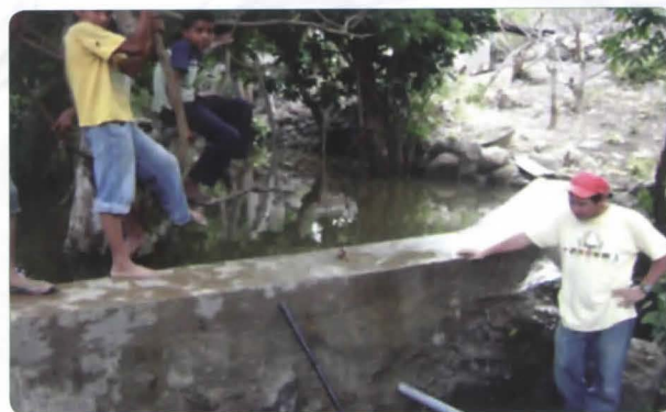
Foto 3. Presa permanente de cemento en quebradas muy pequeñas.
