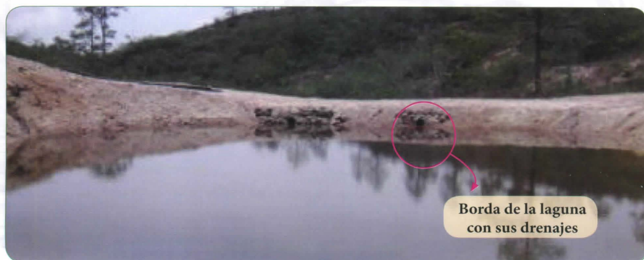
Foto 4. Laguna para riego de alivio, sur de Francisco Morazán.
