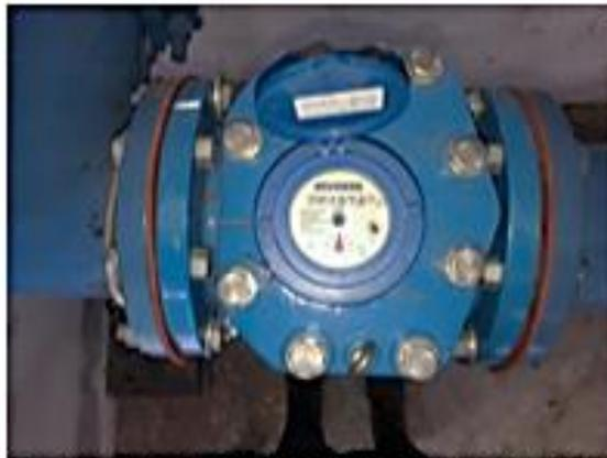
Figura 4. Caudalímetro instalado en el sistema de riego, para medir el caudal entregado por la bomba, en las plantaciones del pivote central de la EAP Zamorano, Honduras.
