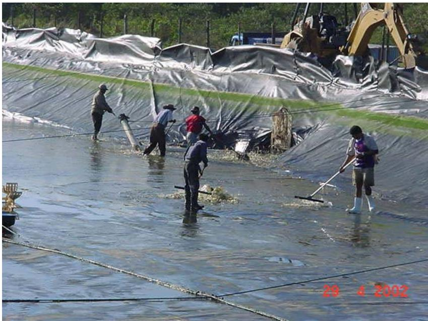
**Figura 5. Revestimiento de estanque de piscina de camaronera intensiva en Ecuador.**
