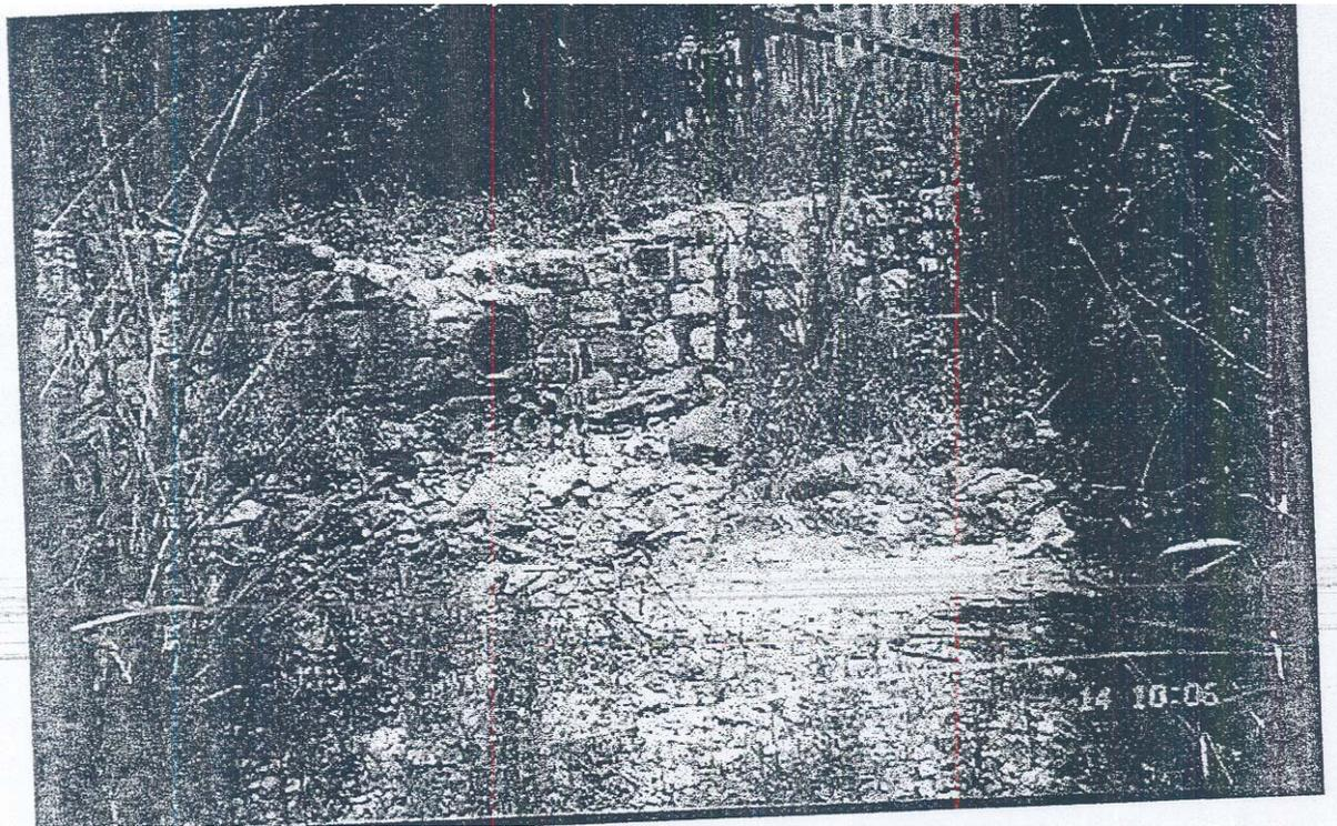
El segundo puente esta ubicado en el acceso a la zona denominada El Espino, este puente tiene una infraestructura que se encuentra por debajo de la superficie de la calle además de que el tubo que conduce el agua es de un diámetro inferior al necesario para evacuar el agua que se conduce a través de la quebrada (Fig. 16).
