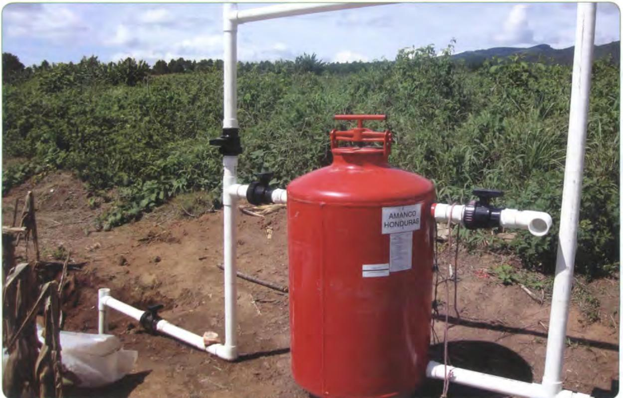
Foto 51. Filtro de arena instalado.
