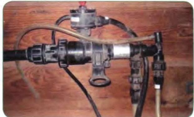
Foto 32. Bomba de inyección eléctrica
