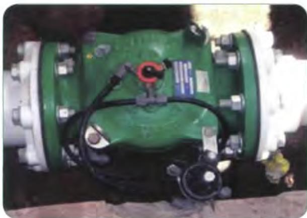
Foto 41. Válvulas hidráulicas de alivio
