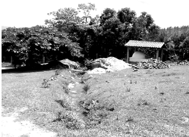
Figura 5. Obras construidas en Parque Comunitario de Galeras.
