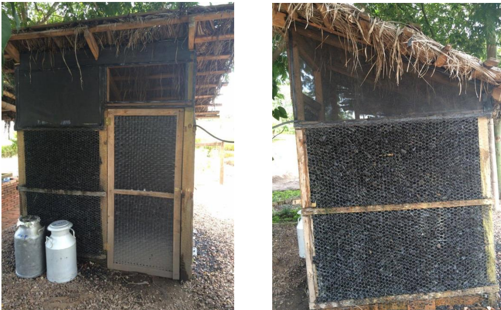
Figura 1. Vista frontal y lateral del COLD STORE®.
