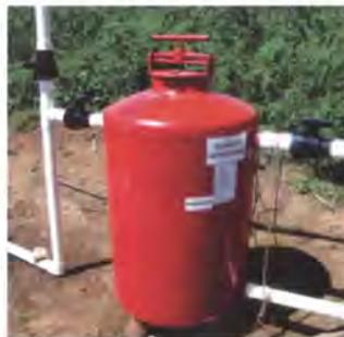
Foto 50. Filtro de arena instalado.
