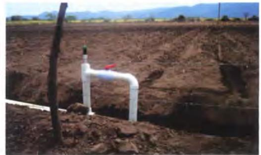
Foto 28. Válvula de aire instalada. Cada válvula de control del paso de agua debe llevar una válvula de aire.
