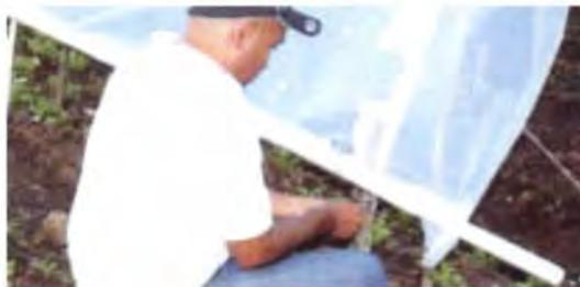
35° Paso: Amarre la punta del tubo lateral a la estaca. En caso de sobrar mucha punta, ésta se puede cortar (asegurándose de dejar tapada la punta para que no se salga la arena).
