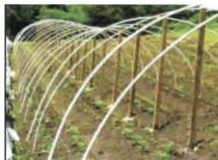
**17° Paso:** Inserte cada arco de PVC en los saques de los postes centrales y sujételos con alambre galvanizado.
