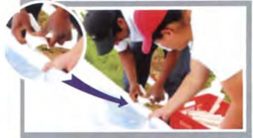
**30° Paso:** Enrolle un poco el plástico al tubo PVC y luego prénselo con sujetadores colocados cada 30 centímetros.
