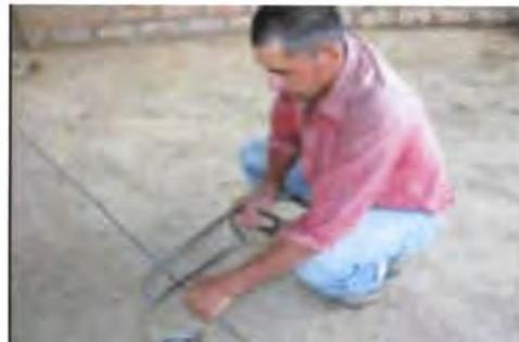
**15° Paso:** Entierre nueve varillas a 50 centímetros de profundidad, cada dos metros.
