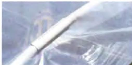
33° Paso: Coloque 15 sujetadores en cada uno de los arcos de los extremos del macrotúnel.
