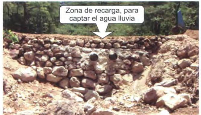
**Foto 5.** Borda de tierra, piedra y cemento construida en un vaso natural.
