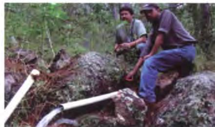
Foto 9. Colocación de un tubo para aforar la fuente de agua.
