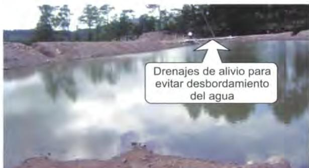
Foto 7. Drenaje de auxilio en la borda de la laguna.
