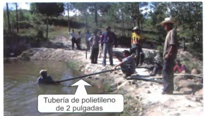
**Foto 6.** Instalación de tubería para conducción del agua de la laguna hacia las parcelas.
