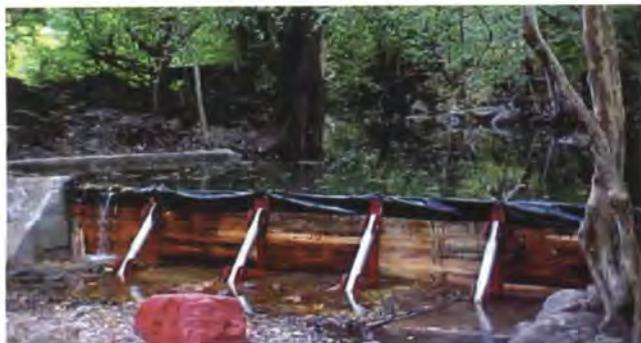
**Foto 1.** Presa provisional de madera en un río para aumentar el nivel de almacenamiento.
