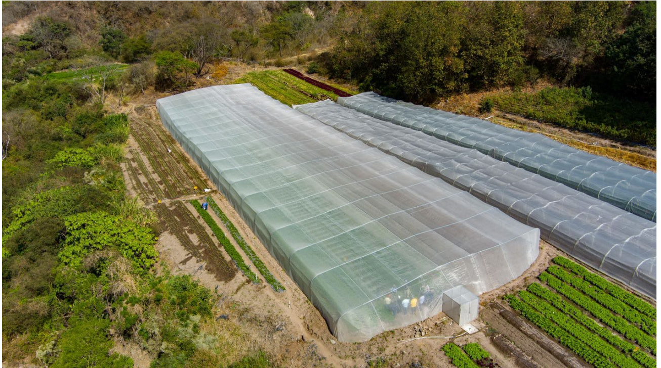
Vista aérea estructura protegida
