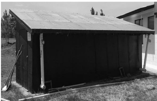
Figura 1. Vista frontal del secador solar para madera aserrada de la Unidad de Forestales, Zamorano.
