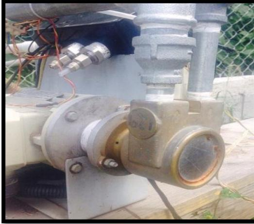
**Motor:** las bombas utilizan un motor de corriente continua de tres fases conocidas como Brushless o BLDC. El motor es un modelo fabricado en India.
