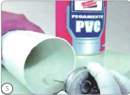
5 Utilizando el brochín, aplicar una capa delgada y uniforme de pegamento en la superficie interior de la conexión (debe ser delgada para evitar debilitamiento excesivo de la pared). Aplicar también con el brochín una capa generosa sobre el exterior del tubo.
