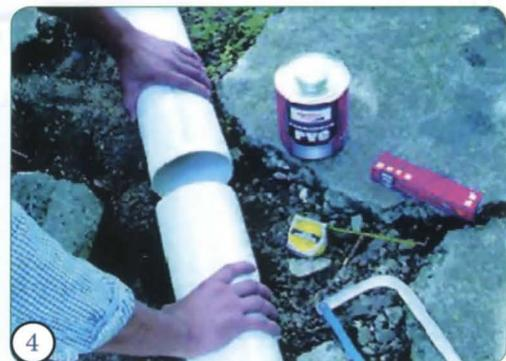
Una las piezas en seco, para comprobar que el tubo y el accesorio encajan.
