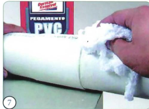
7 Limpie el exceso de pegamento. Espere dos horas antes de manipular y 24 horas antes de hacer la prueba de presión.
