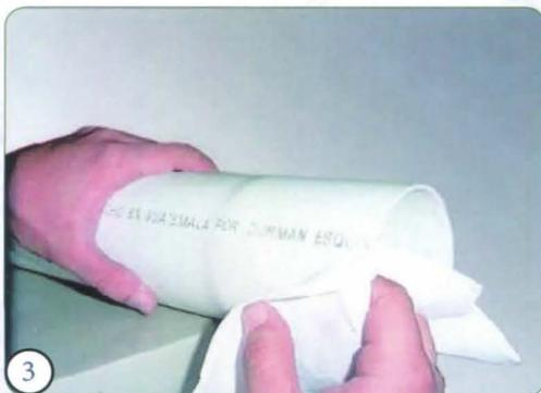
Limpie el tubo e interior de la conexión con un trozo de tela limpio y humedecido con limpiador de PVC.
