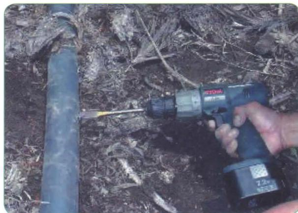
Foto 89. Perforación de tubería.
