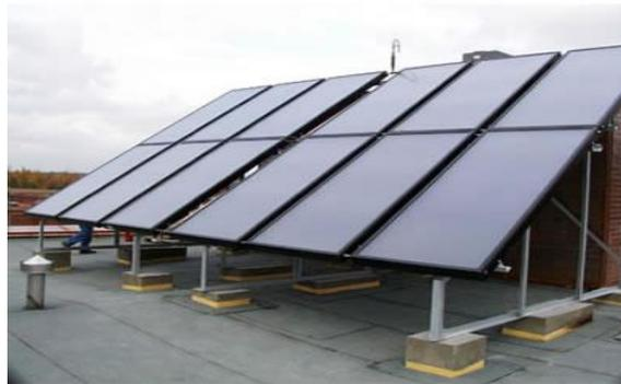
Figura 2. Calentador solar de placa plana con cubierta
