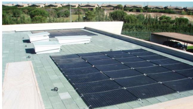
Figura 5: Calentador de placa plana sin cubierta
