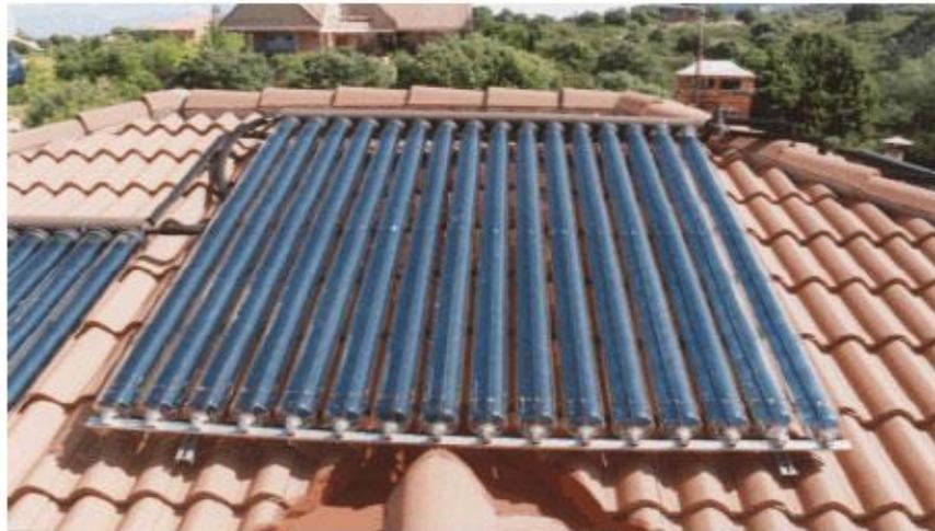
Figura 8. Calentador Solar de Tubo de Vacío
