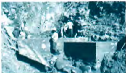
Miembros de la comunidad de El Plan, Tatumbra, trabajando en la reconstrucción de la pila receptora de agua.
