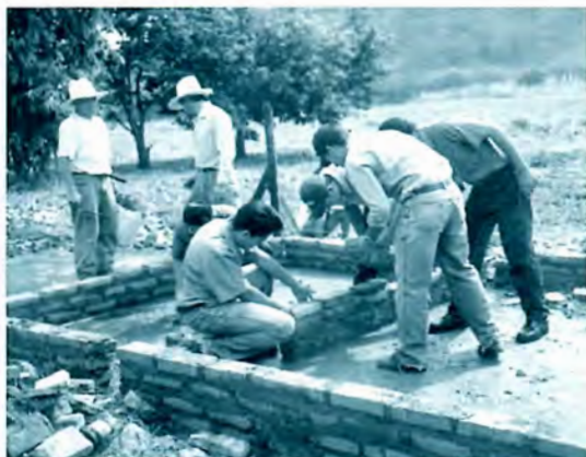
El grupo de estudiantes de apoyo permanentes UNIR participó en la construcción de porquerizas en la casa de beneficencia REMAR en la comunidad de las Mesas, San Antonio de Oriente.
