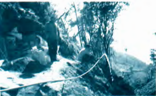
Después de un ardua jornada de trabajo el líquido preciado empieza a salir por las tuberías que irán directamente a la comunidad.
