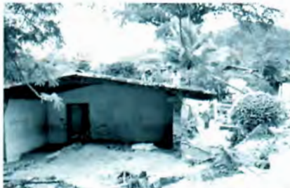
La destrucción de la infraestructura después del paso del huracán Mitch causó grandes pérdidas económicas y humanas.
