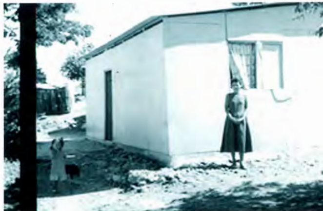
Zamorano con el apoyo de amigos de la comunidad internacional construyó albergues para las familias que perdieron su vivienda.
