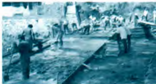
Trabajos de construcción del puente que conduce a la comunidad del Llano del Ocotál.
