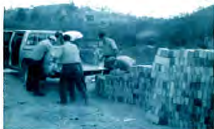
Entrega de material de construcción a la casa de beneficencia REMAR para la construcción de porquerizas por parte de estudiantes de Zamorano.
