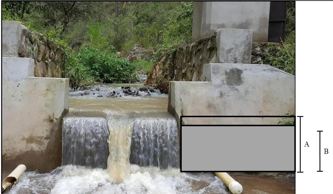
Figura 4. Diferencia entre la estación limnométrica y la estructura sólida del vertedero.
