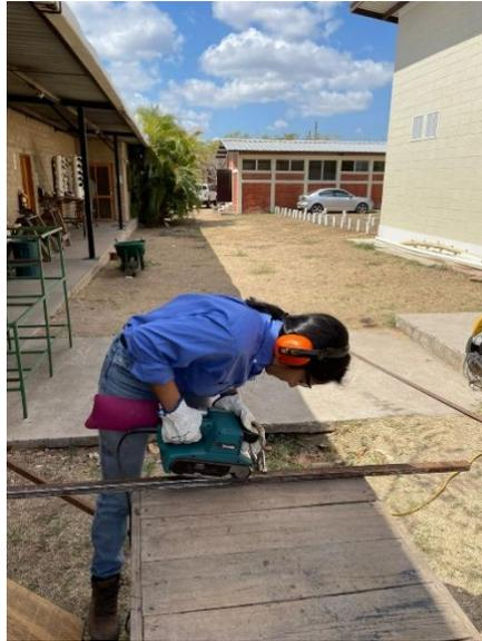
Se comenzó a construir la base en donde se colocó el filtro, donde el primer paso fue cortar los tubos cuadrados de metal y luego ligarlos. Este paso se lo realizó con el fin de soldar todas las partes y luego pintarlas.
