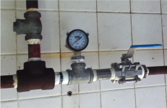
Anexo 4. Medición de presión con la instalación de un manómetro.
