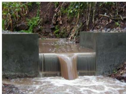
Fig 4: Vertedero “V-notch” en funcionamiento.
