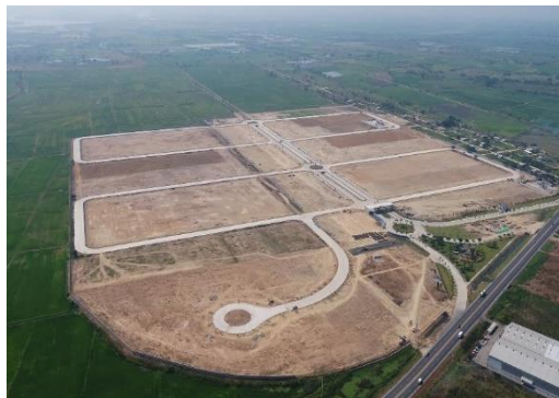
Figura 1. Parque Industrial de Acopio y Distribución Yaguachi (PIADY) Fuente: PIADY 2019
