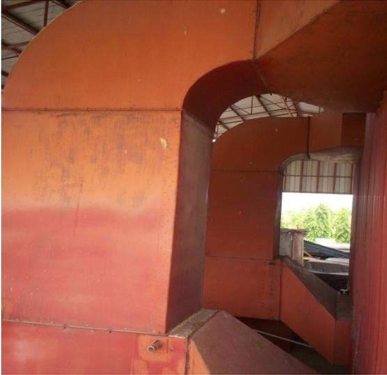
Figura 23. Conductos de entrada de aire caliente.
