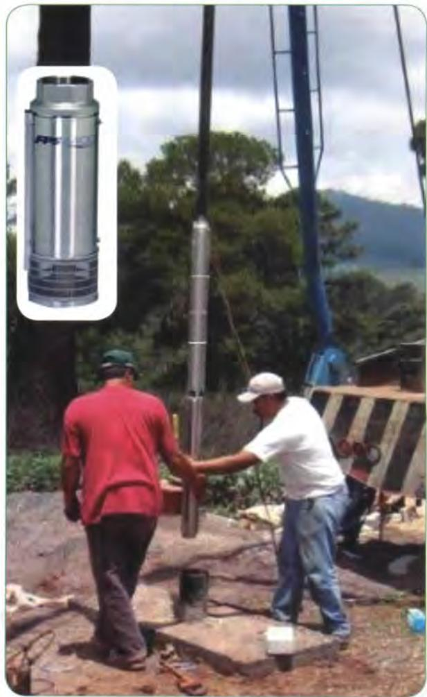
Figura 23. Bomba Sumergible
