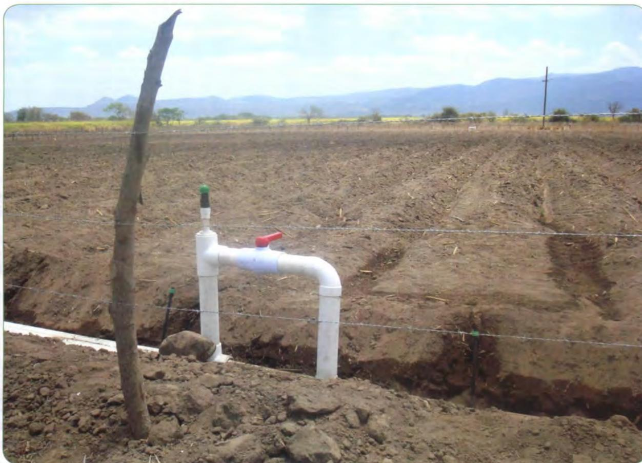
Foto 28. Válvula de aire instalada. Cada válvula de control de paso de agua debe llevar una válvula de aire
