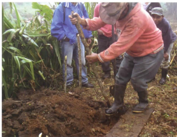
Foto 14: Primera zanja de la cama (R. Andrango)
