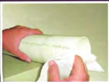
3. Limpie el tubo e interior de la conexión con un trozo de tela limpio y humedecido con limpiador de PVC.
