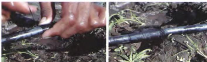
**Fotos 94 y 95.** Reparación de fugas utilizando neumático de bicicleta o moto.
