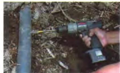
Foto 96. Perforación de tubería.
