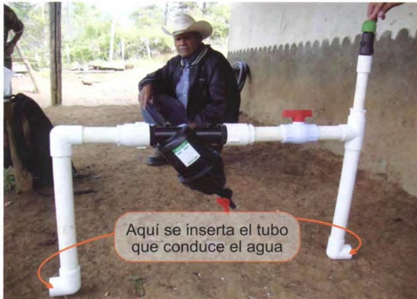
Foto 103. Válvula de control armada, con filtro y válvula de aire.
