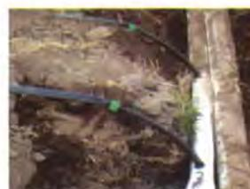
Foto 99. Elevadores de polietileno de 16 mm, comúnmente llamados tubines.
