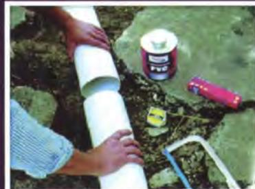
4. Una las piezas en seco, para comprobar que el tubo y el accesorio encajan.
