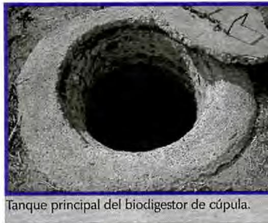
Tanque principal del biodigestor de cúpula.
