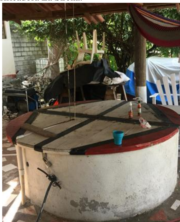
Anexo 12. Pozo de purificadora La Sirena.
