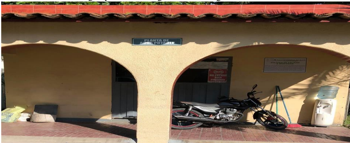
Anexo 1. Planta de agua potable del ingenio Los Mangos.
