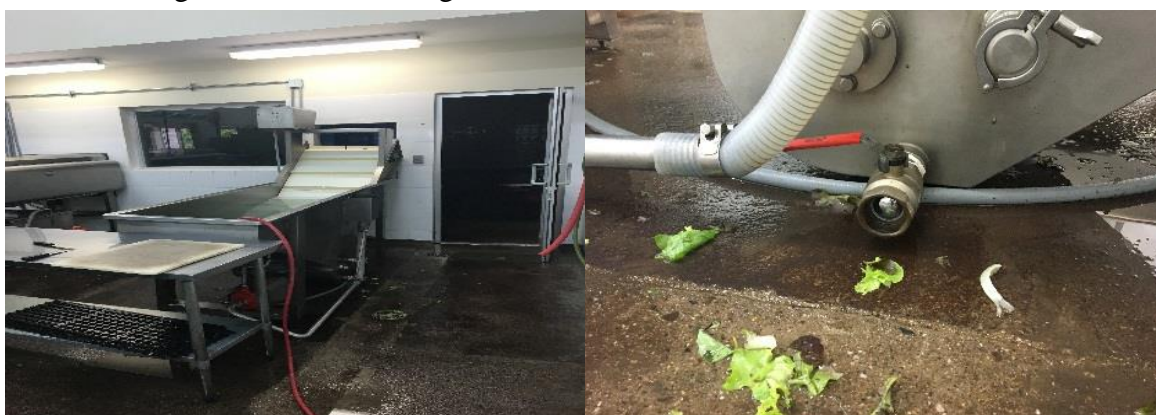
Anexo 4. Lugar de muestreo de aguas residuales de la Planta de Poscosecha de la EAP.
