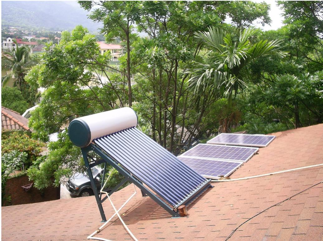
Figura 1. Fotografía de un CSA termosifónico con colector de tubos evacuados tomada en una vivienda en la ciudad de San Pedro Sula.
