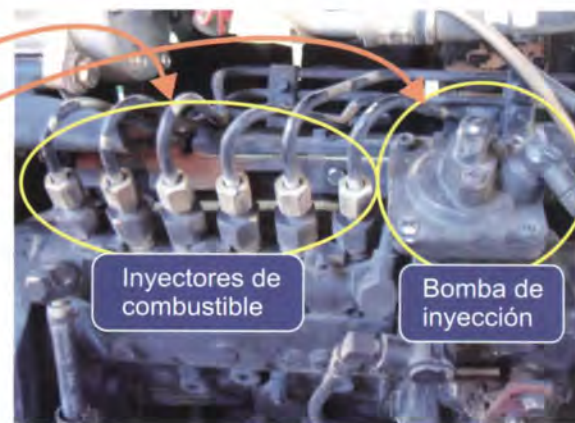
Foto 33. Inyectores y bomba de inyección.
