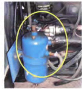
Foto 31. Filtro trampa de agua.
