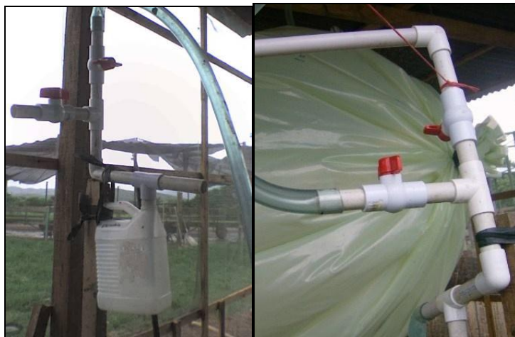
Figura 6. Válvulas de seguridad, transporte y medición del biogás producidos en los biodigestores.
