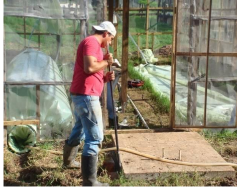
Figura 8. Formación de los canales de conducción de los efluentes de los biodigestores a la caja de pasaje de aguas.
