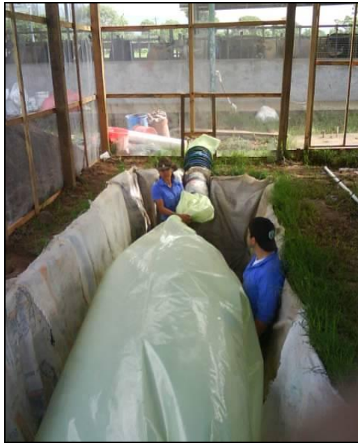
Figura 7. Instalación del tubular de polietileno en la fosa.
