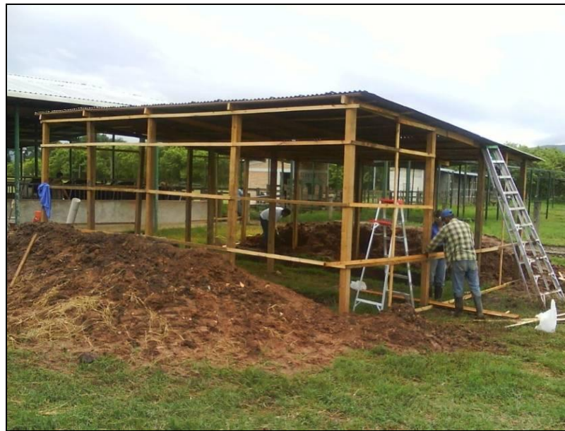
Figura 4. Construcción de la estructura de protección de los biodigestores Tipo Taiwán.
